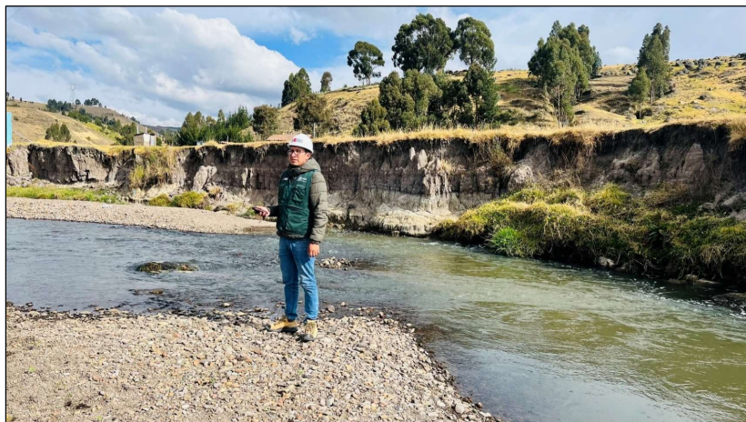
FIGURA N°04: TRAMO CRÍTICO DEL RIO MATARAYOCC, MARGEN DEL RIO VULNERABLE.
